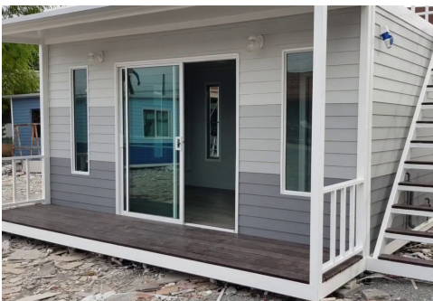
บ้านประกอบเสร็จ
